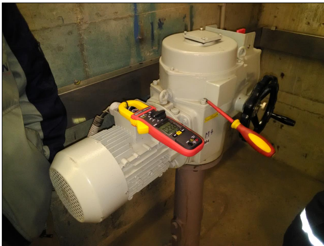
Obr. 7 Servopohon uzávěru M4
