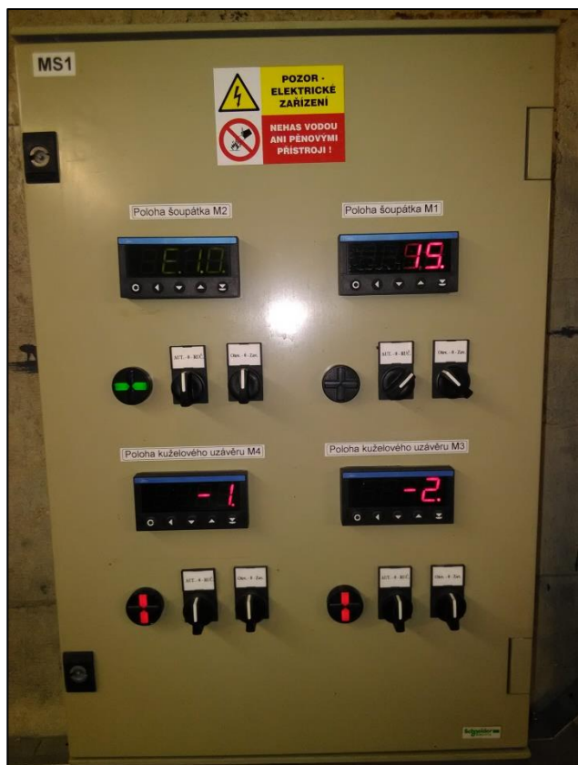
Obr. 5 Rozvaděč ovládání, levý horní ukazatel nefunkční
